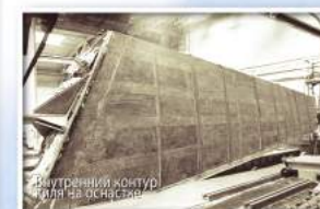
Изготовление опытного отсека киль
