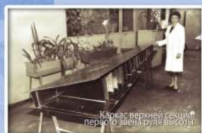
Каркас секций руля направления
