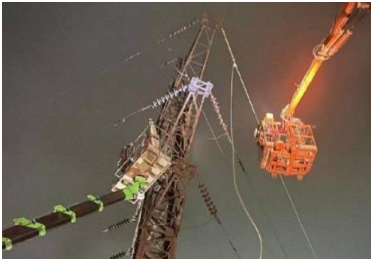
Рисунок 1.2 – Відновлення високовольтних ліній електропередач
