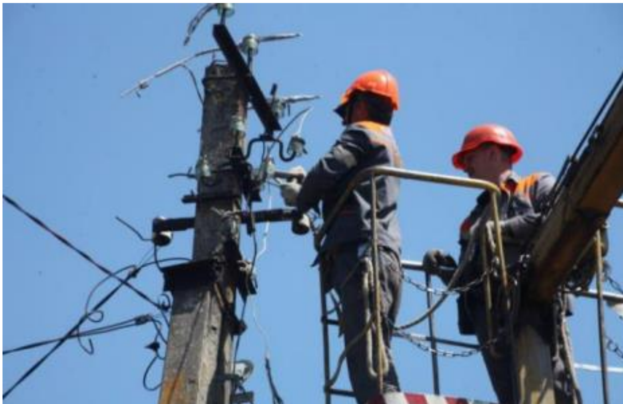
Рисунок 1.1 – Відновлення електропостачання населених пунктів
