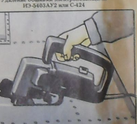
Высверлить в опорной пластине центр и вырезать поврежденный участок циркулярным резаком. Обработать кромки.
