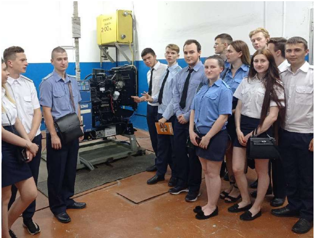
Дизельний генератор автономної системи живлення.
